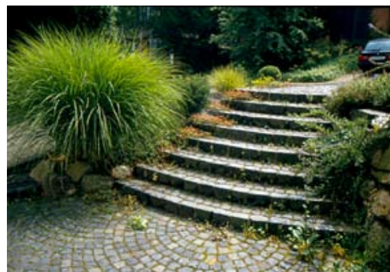
▲ Z dlažebních kostek se dají vytvořit velmi efektní tvary schodiště. Schody se v takovém případě mohou stát důležitou dominantou zahrady
