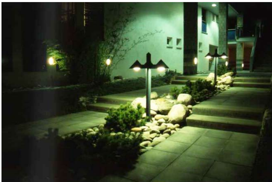
Vhodný typ osvětlení zajistí bezpečný pohyb v okolí domu.
